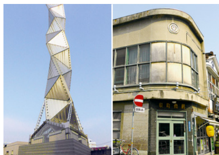
水戸芸術館 アートタワー 泉町会館
